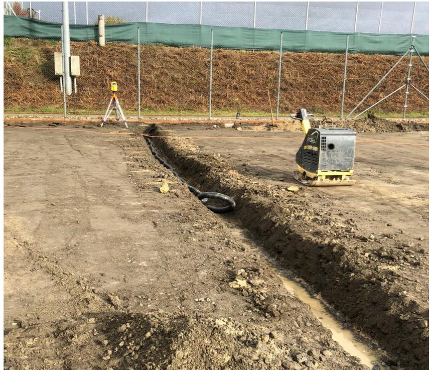
Im Zuge der Tennisplatzsanierung wurde zur besseren Entwässerung bei Starkregen ein Drainagensystem eingebaut.
