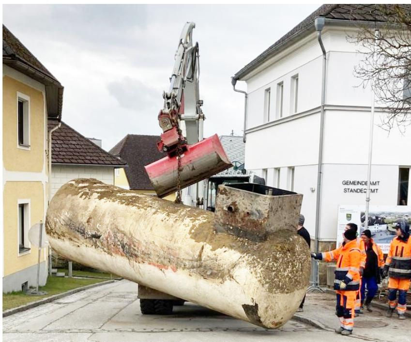
Im Zuge der Vorplatzarbeiten wurde der alte Öltank ausgegraben und ordnungsgemäß entsorgt.
