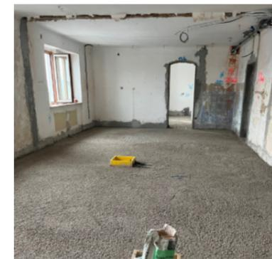
Die Innenputzarbeiten im Gemeindehaus sind soweit abgeschlossen. Die Schüttung im OG wurde errichtet und in weiterer Folge wird der Estrich aufgetragen. Im EG wurde die Fußbodenheizung in den bestehenden Estrich eingefräst. Ein neues Eingangsportal auf der Nordseite des Hauses soll demnächst montiert werden.
