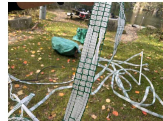
Das Foto zeigt die Elektrodenleitung, welche am Boden der Resilacke verlegt wurde.
